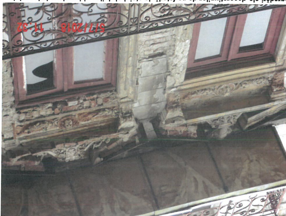
Fig. 17. Degradări ale decorațiilor de pe fațadă, la etajul al doilea și imaginea balconului nou realizat care nu respectă imaginea originală a imobilului, alterând ritmul fațadei eclectice Sursa: http://amccrs-pmb.ro/proiecte/punere in siguran%C7Aa/strada selari, nr 22
