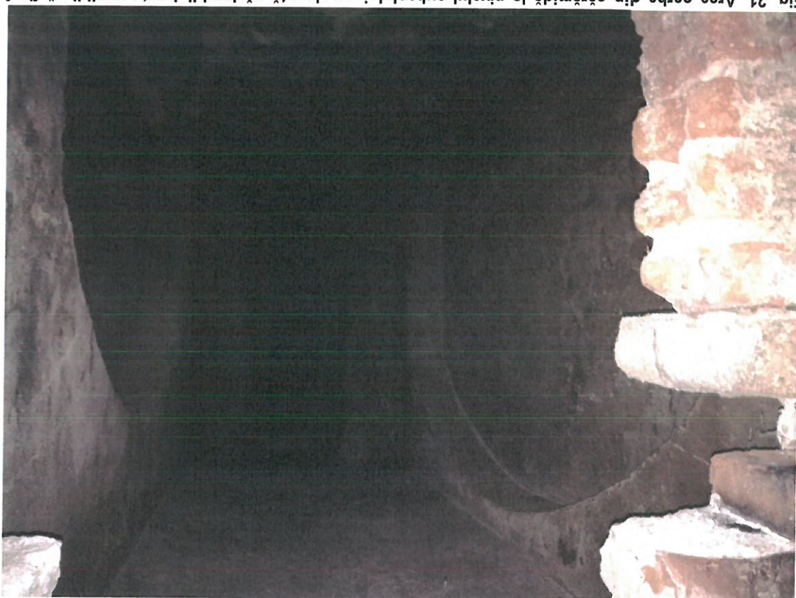
Fig. 21. Arce oarbe din cărămidă la nivelul subsolului, ce denotă că imobilul este posibil să fie fost construit pe fundațiile unei construcții anterioare ( din secolul al XVIII –lea) Sursa: arhiva Companiei Municipale de Dezvoltare Durabilă București
