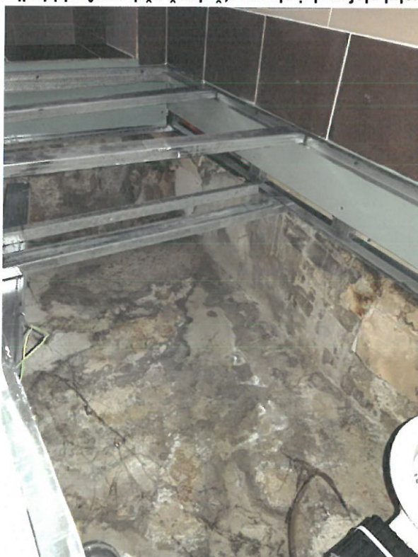
Fig. 13. Igrasie avansată la nivelul plafonului observată după căderea închiderilor tavanului fals Sursa: arhiva Companiei Municipale de Dezvoltare Durabilă București
