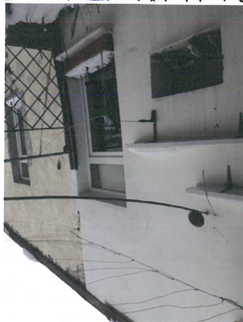
Fig. 13. Igrasie avansată la nivelul plafonului observată după căderea închiderilor tavanului fals Sursa: arhiva Companiei Municipale de Dezvoltare Durabilă București
