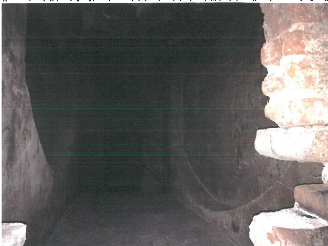
Fig. 8. Arce oarbe din cărămidă la nivelul subsolului, ce denotă că imobilul este posibil să fie fost construit pe fundațiile unei construcții anterioare, posibil din secolul al XIX-lea Sursa: arhiva Companiei Municipale de Dezvoltare Durabilă București
