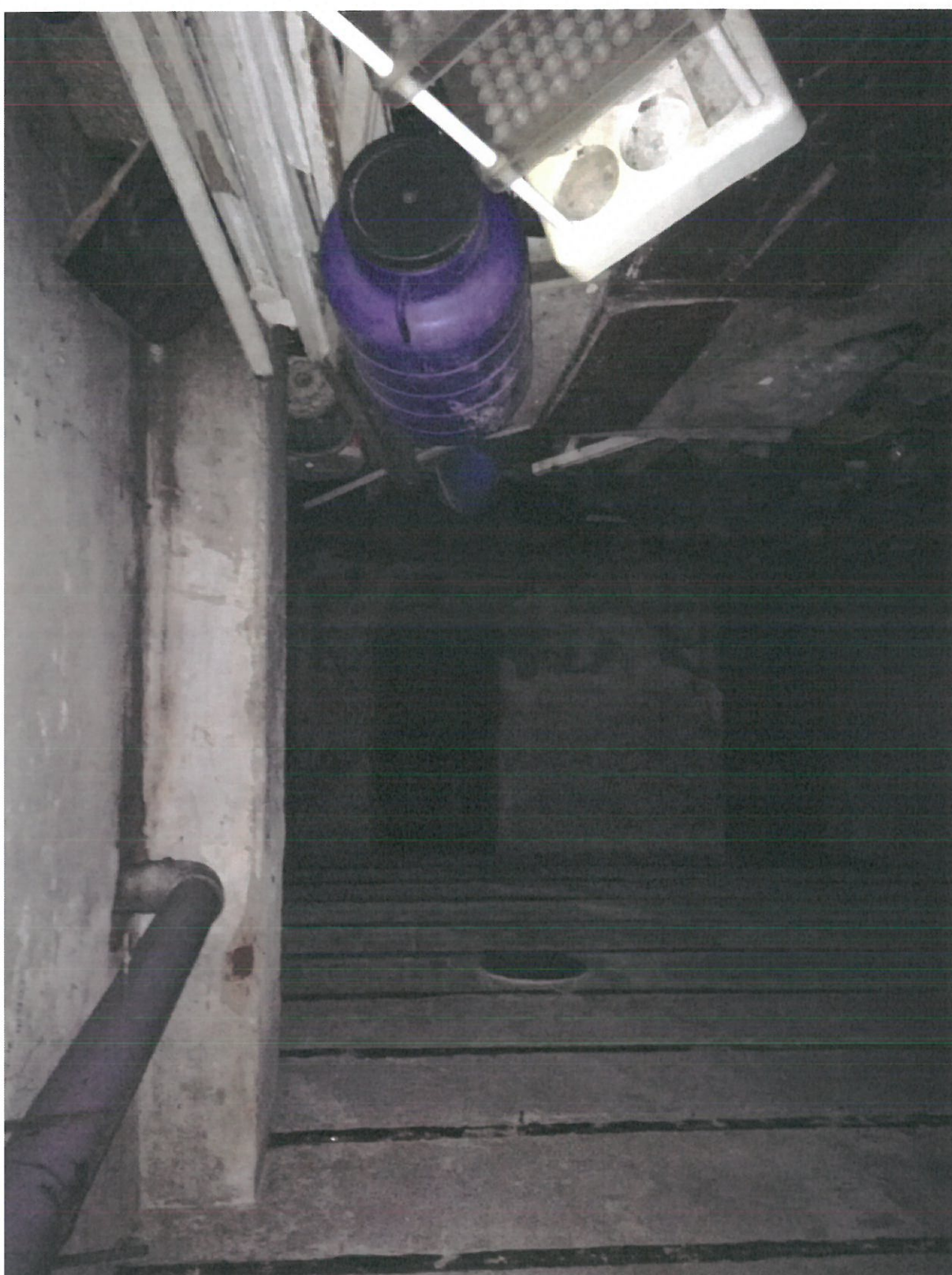
Fig. 7. Modul de realizare al planșei peste subsol cu boltișoare de cărămidă sprijinite pe grinzi din profile metalice Sursa: arhiva Companiei Municipale de Dezvoltare Durabilă București
