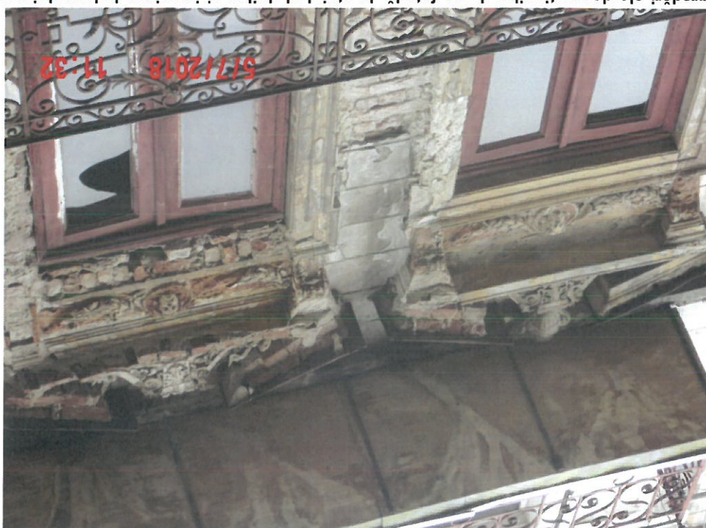
Fig. 3. Degradări ale decoraţiunilor de pe faţadă, la etajul al doilea şi imaginea balconului nou realizat care nu respectă imaginea originală a imobilului, alterând ritmul faţadei eclectice
