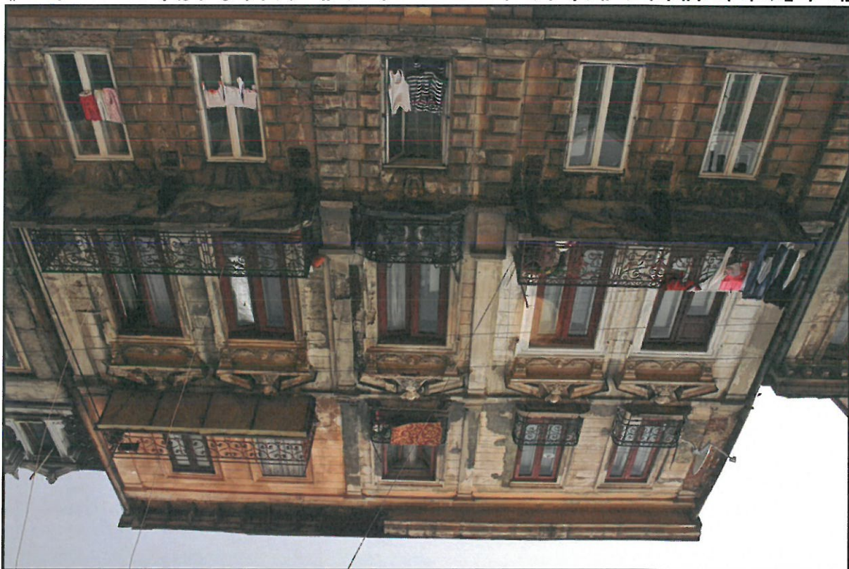
Fig. 3. Degradări ale decoraţiunilor de pe faţadă, la etajul al doilea şi imaginea balconului nou realizat care nu respectă imaginea originală a imobilului, alterând ritmul faţadei eclectice
